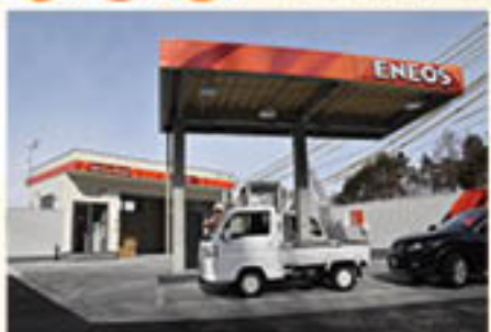
2月にオープンした大岡給油所
