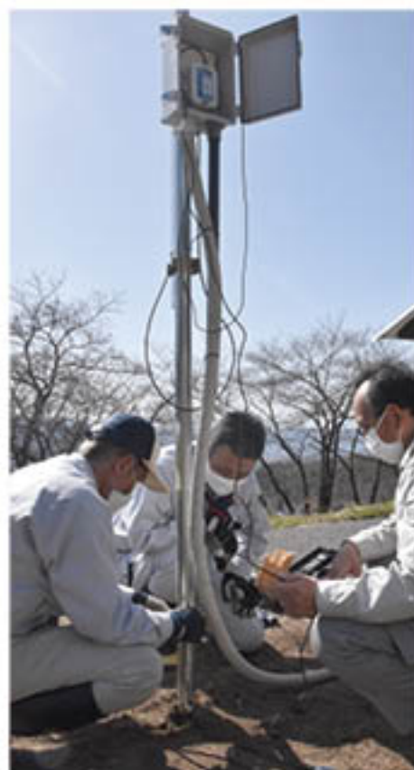
営農技術員と業者が機器の設置状況を確認
