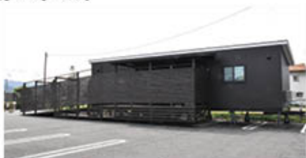
設置した通夜用のトレーラーハウス
