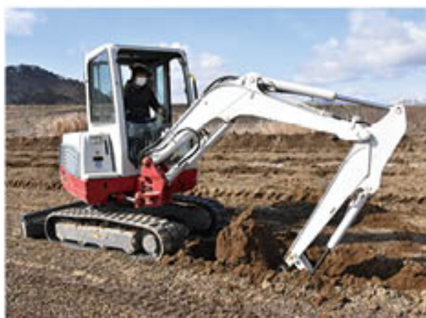
重機で掘り取り用の穴を掘る生産者
