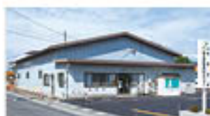
更北営農資材センター
